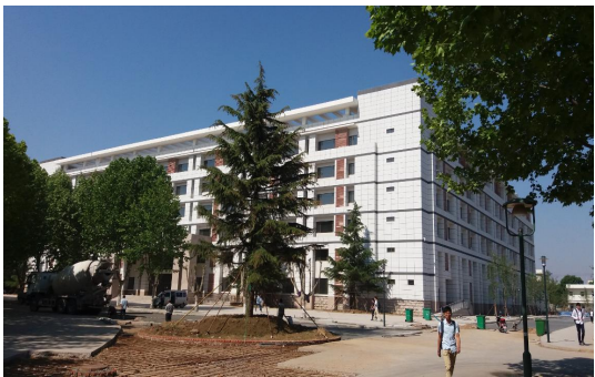
图 3-3 新建科技大楼
